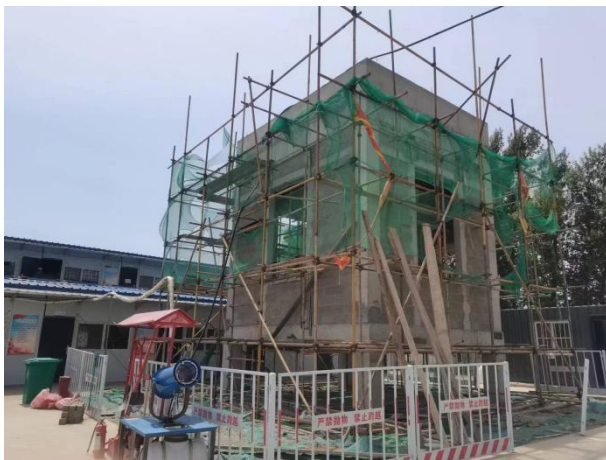
医疗垃圾暂存库
